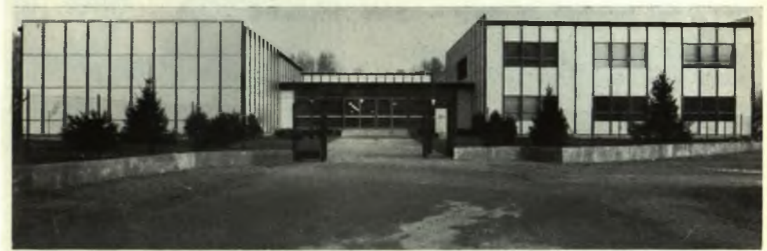
Scuola prefabbricata multipiano - Mantova - Viale Montello
