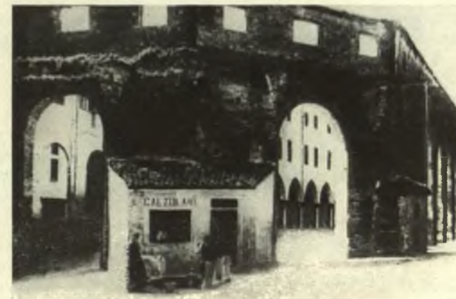
Gli archi fatti costruire nel 1580 dal Duca Guglielmo Gonzaga per sorreggere il corridoio che dalla corte metteva alla tribuna ducale nella Chiesa di S. Pietro.
