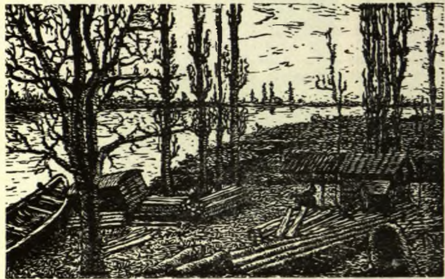
Piccolo cantiere sul Po
