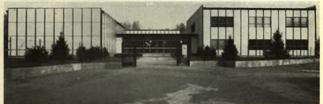
Scuola prefabbricata multipiano - MANTOVA - Viale Montello
