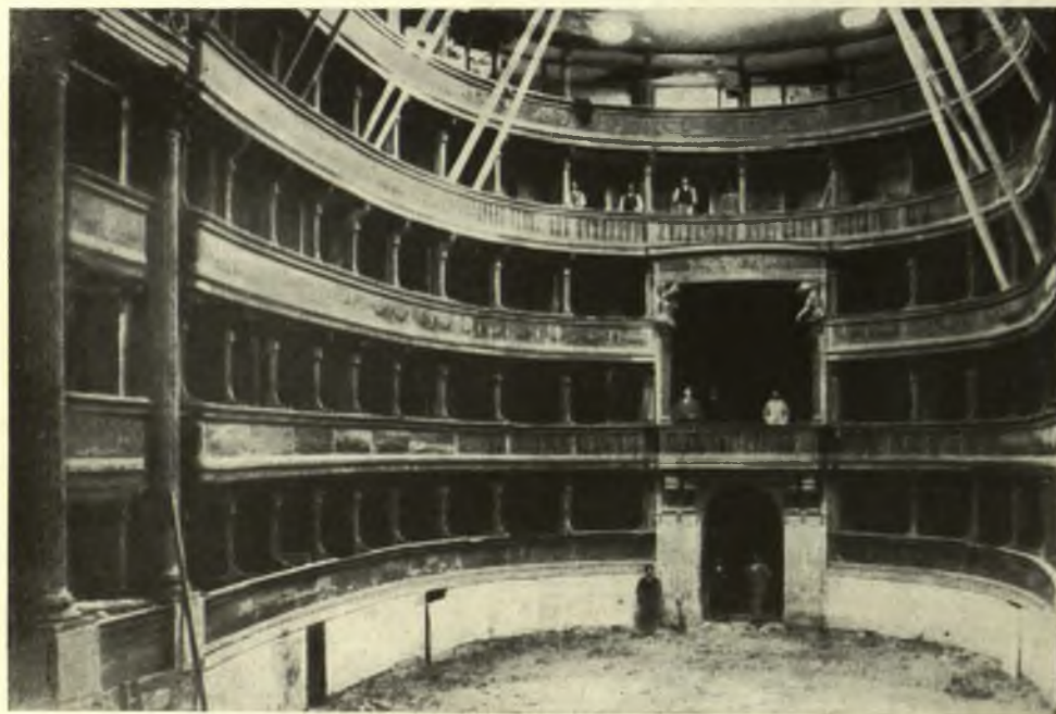
Il Regio Ducale Teatro Nuovo in Mantova, costruito su progetto di Giuseppe Piermarini, in demolizione. 1898 (Mantova, collezione della Marchesa d'Arco)
