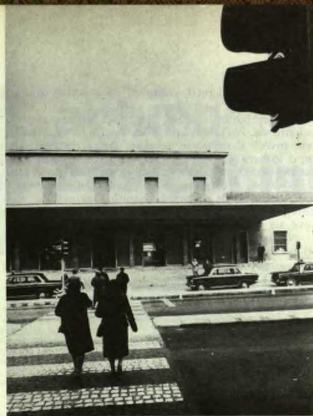
La circolazione in Piazzale Don Leoni, di fronte alla Stazione FF. SS., già regolata con il nuovo impianto semaforico.
