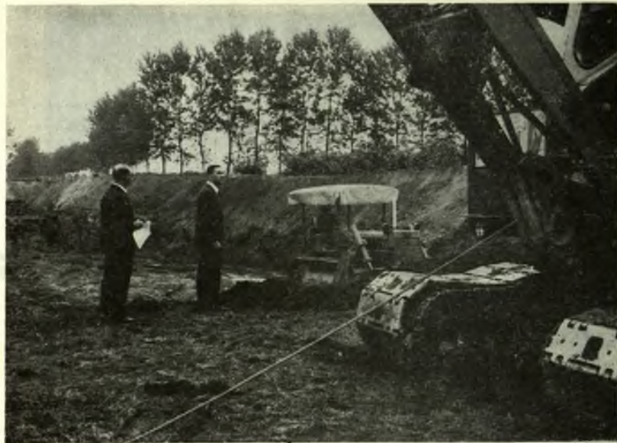
Lavori in corso per un impianto di stoccaggio di gas metano
