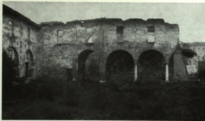
I resti del chiostro, che saranno restaurati ed incorporati nel progetto della nuova scuola
