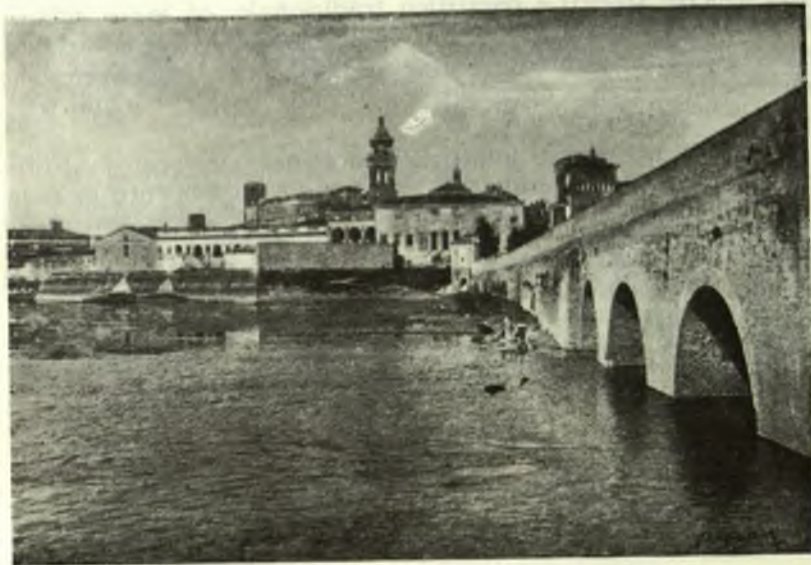
Il vecchio ponte di S. Giorgio con le arcate in muratura ora ricoperte dal terrapieno...
