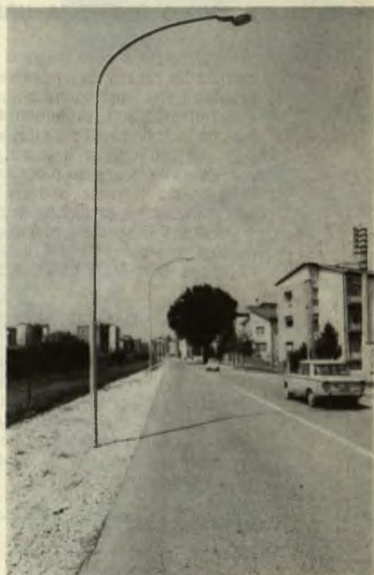
Nuova pavimentazione e illuminazione in viale Montenero.
