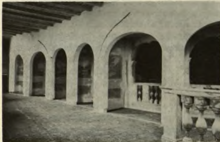
I solai in legno sono stati completamente rifatti, come appare da questa veduta dell'ultima galleria.
