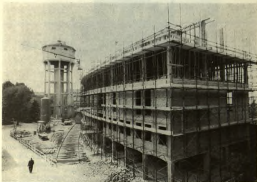
La nuova infermeria dell'Istituto Geriatrico in costruzione.
