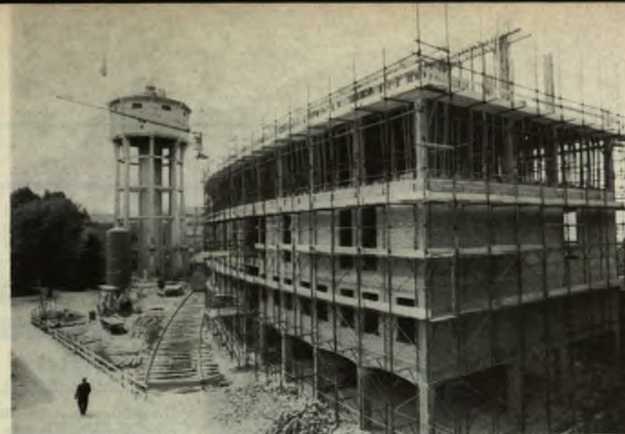
La foto mostra i lavori in corso di avanzata esecuzione per la nuova infermeria dell'Istituto Geriatrico di Via Trento.
