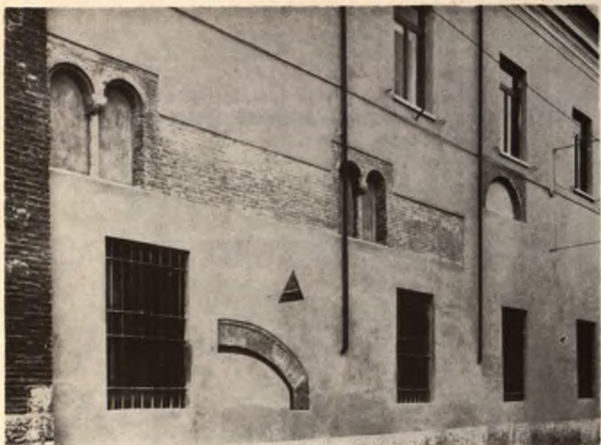
Mantova. Sede dell'Archivio di Stato. Particolare della facciata dopo il restauro. (Foto Giovetti, Mantova)
