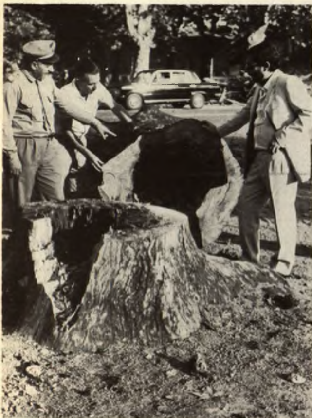
Demolizione e sostituzione di quelli morti
