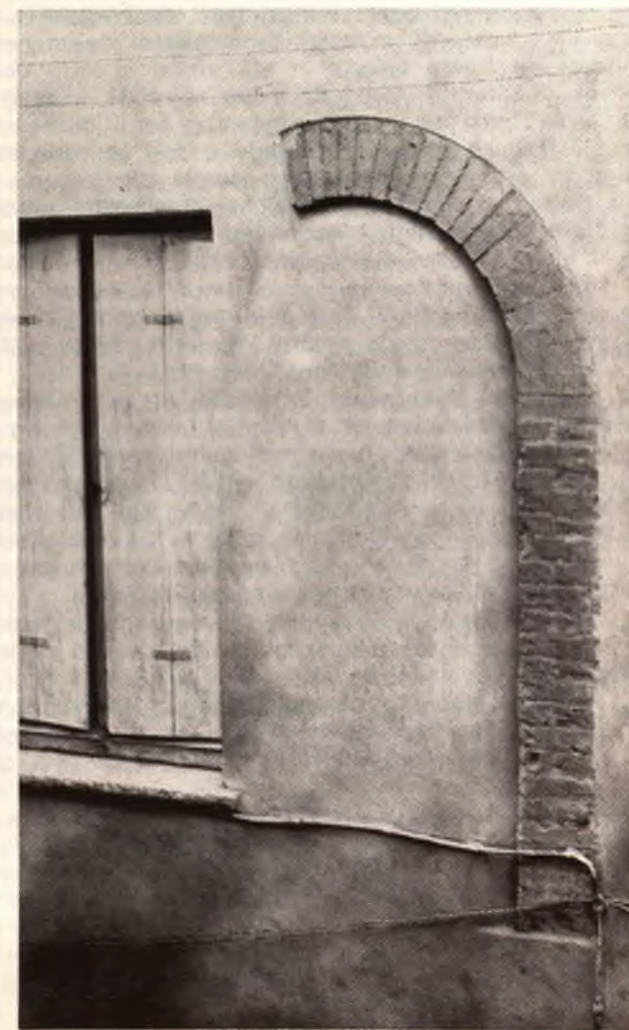
Casa di Vicolo S. Maria. Lo stesso dopo il restauro.
