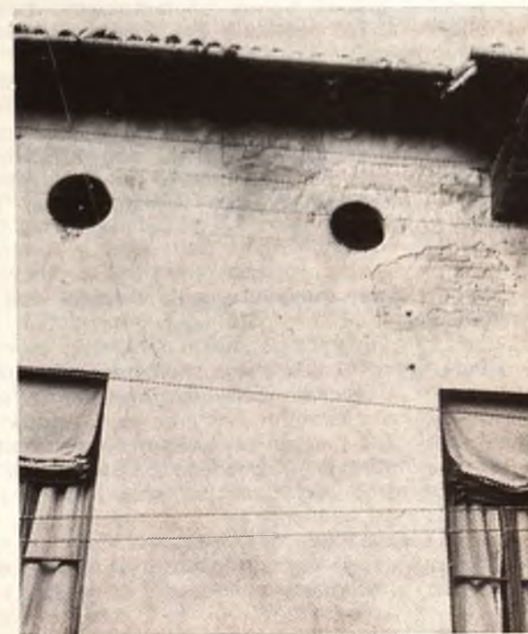
Casa di Via F.lli Bandiera. Prima del restauro.
