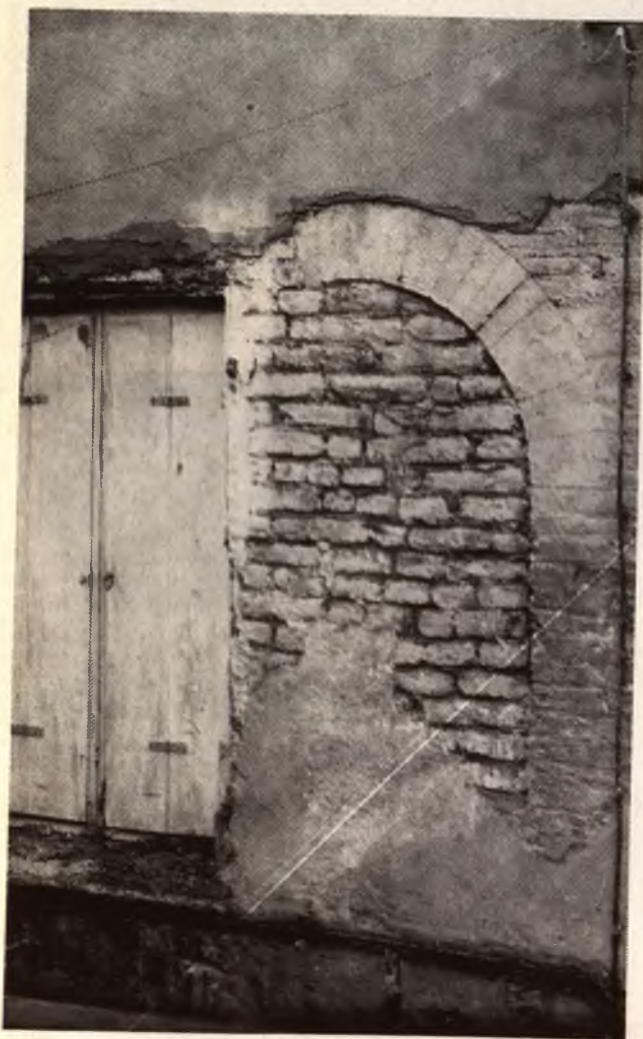
Casa di Vicolo S. Maria. Particolare prima del restauro.
