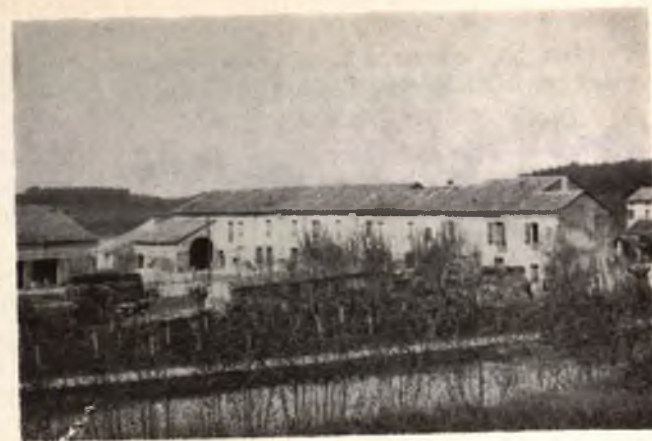
Fig. 1. Carbonara. Casa Dalla Valle.
