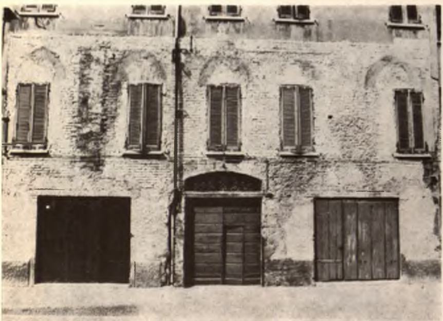
Mantova. Casa demolita di via della Conciliazione n. 43. racciata.
