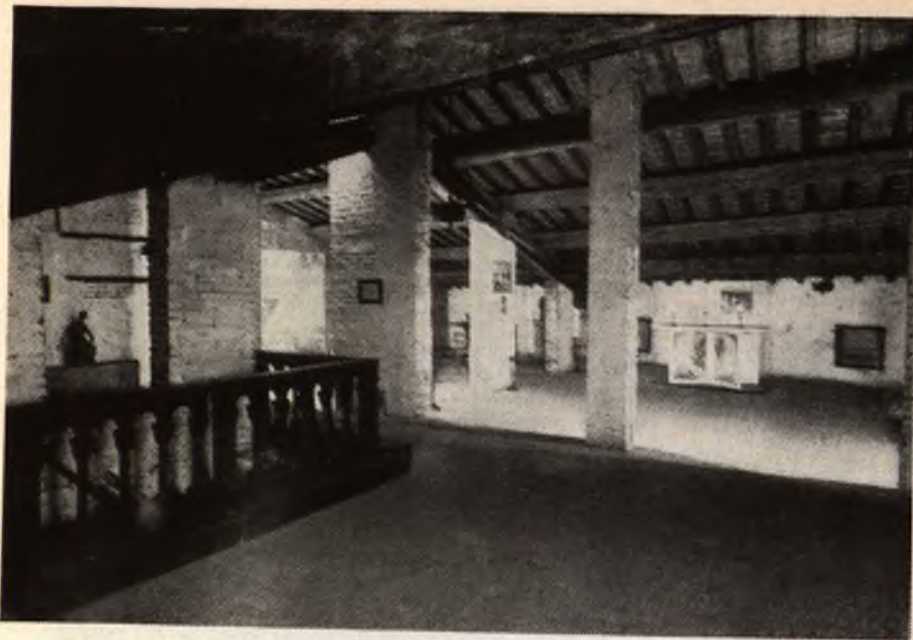
Casa della Beata Osanna. La grande soffitta restaurata.
