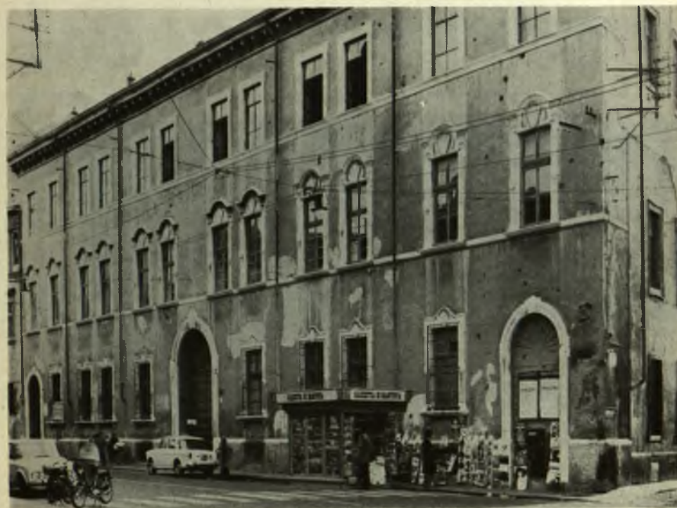
Questa è la facciata della Scuola Media G. Romano: il suo restauro è in corso. In apertura d'articolo: la facciata di un vecchio edificio scolastico (Elementari « Cardone » a Frassino) come esempio di ottimo, complessivo recupero.
