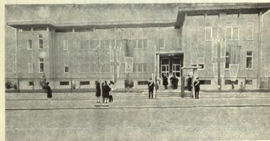
Mantova - Valletta Paiolo - L'edificio della nuova scuola elementare.
